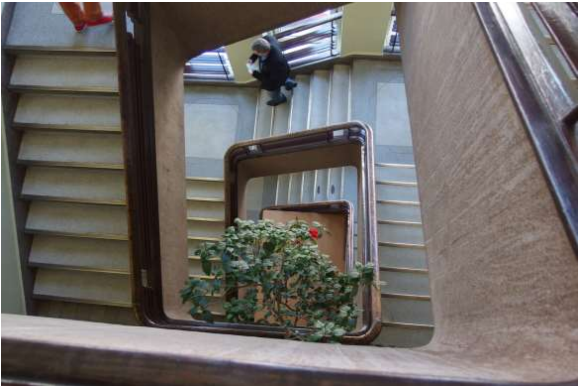
Fot. 6 Miejsce montażu podnosnika dla osób niepełnosprawnych w budynku przychodni
